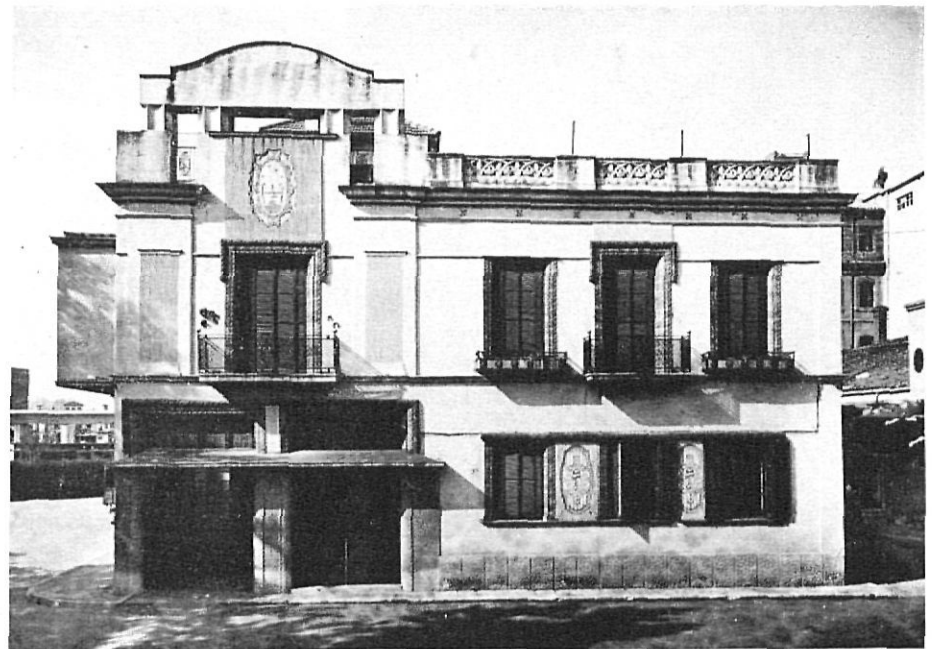
Detall façana principal Casa Ensesa. 1913-15. Girona.
