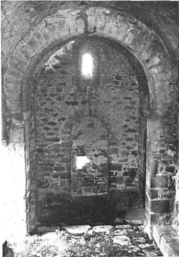
Fig. IV. — Interior de la crugia frontal de Santa Fe amb l'arc toral
