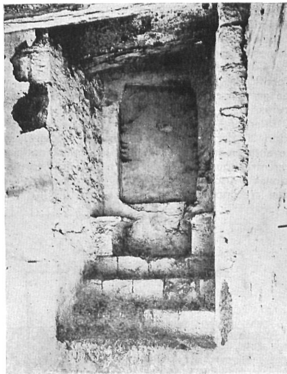
SANT JOAN LES FONTS. — Mas Juvinyà . Estado actual de una de las ventanas con «festejadores», de la planta noble (Foto Servicio Monumentos. Diputación Barcelona)
