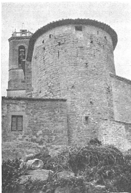
COLOMERS. Abside fortificado y recrecido de la iglesia, actualmente en restauración a cargo de la Diputación. (Foto Jaime Marqués)
