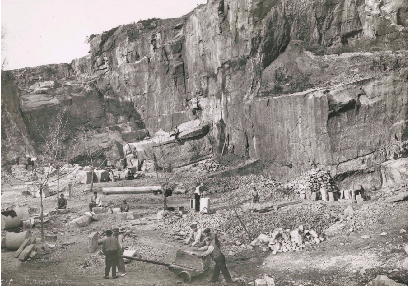
>> Picapedrers treballant en una pedrera, 1920-1930. En primer terme, un carro de llança per al transport de blocs. (Foto: AJUNTAMENT DE GIRONA. CRDI. AUTOR DESCONEGUT.)
