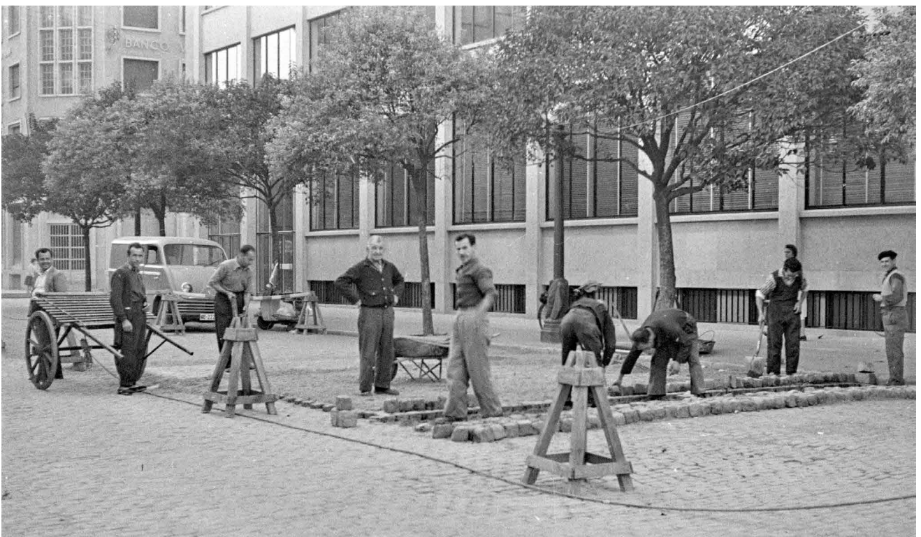
>> Operaris col·locant llambordes a la Gran Via de Jaume I, 1960-1970. (Foto: AJUNTAMENT DE GIRONA. CRDI. SALVADOR CRESCENTI MIRÓ.)
