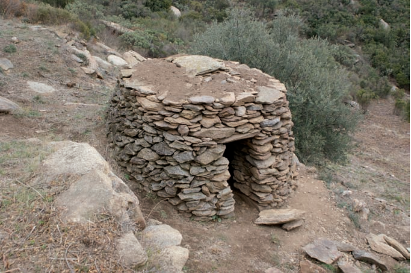
>> Barraca d'en Garrigàs, a Vilajuïga, després de la seva restauració.
