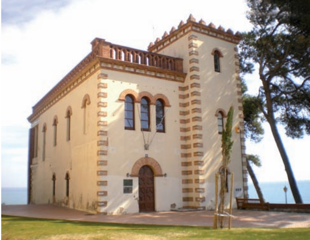
>> Vista de la Casa Forestal, edificada el 1909
