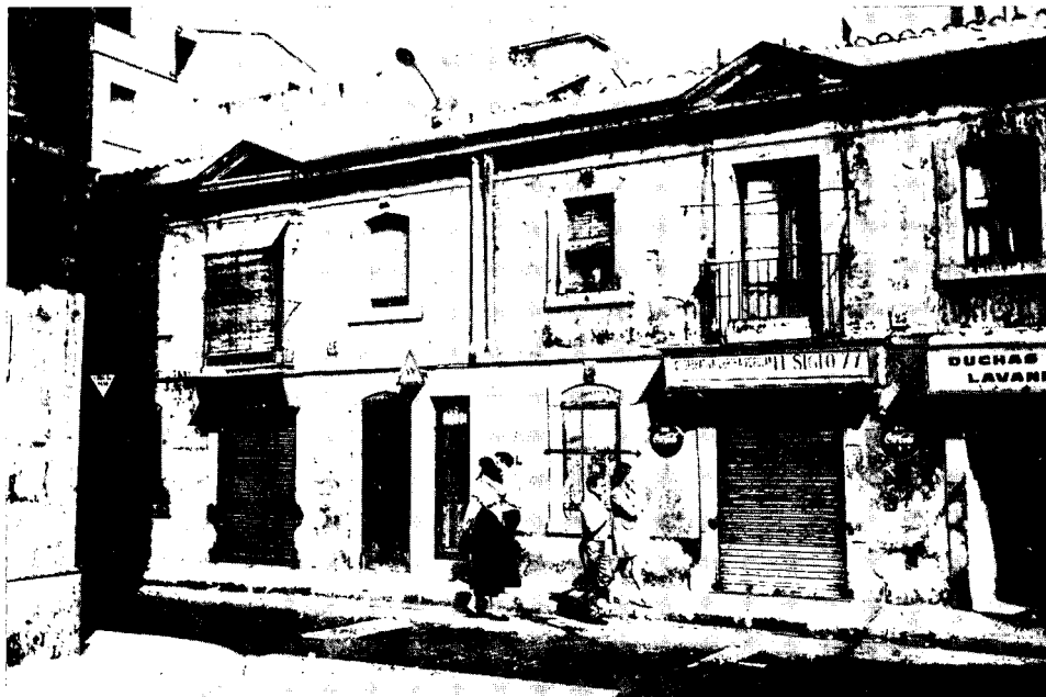
Dos casas del siglo XVIII en la Plaza de la Fuente. Al subdividirse la vivienda la planta baja ha sido convertida en locales comerciales y se ha construido una puerta adicional que conduce al primer piso. La falta de servicios en la vivienda se refleja en la existencia de un establecimiento dedicado a duchas y lavandería (Fotos H. Capel).
