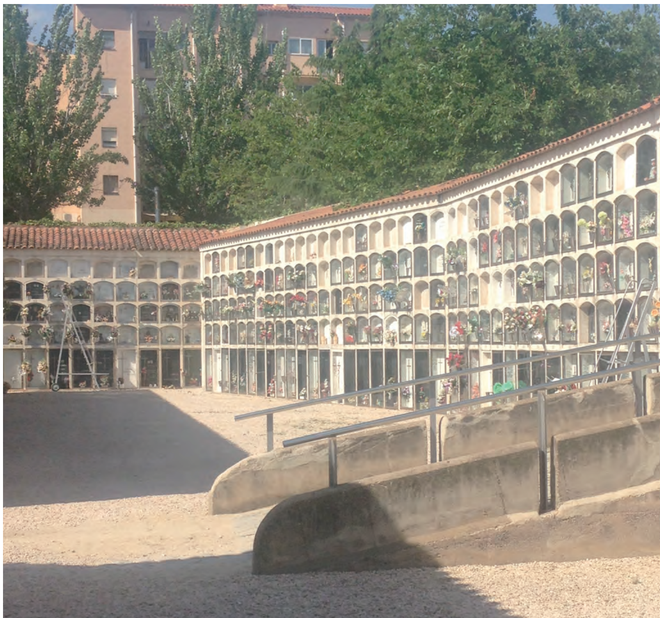
Blocs de nínxols. Cementiri Vell d'Igualada (2016) GARCIA-TORRA
