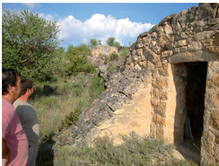
Mostrant els contraforts de la cabana de volta.
