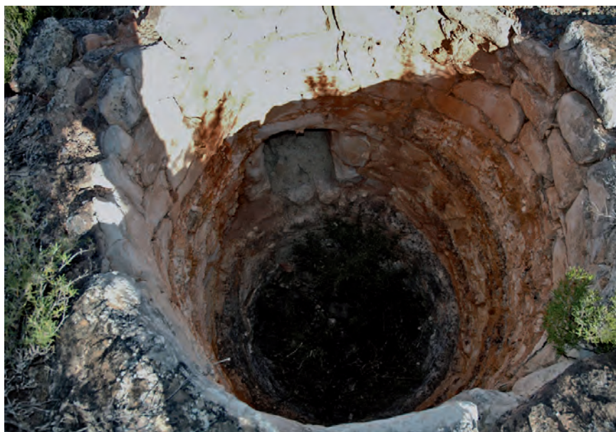
■ Forn de calç del Jenaro. És una construcció de pedra, de forma cilíndrica i sense coberta, on es coïen pedres calcàries per obtenir calç. Té una obertura a la base per tal de poder introduir la llenya a l'interior durant el procés de cocció. MATEU ESQUERDA - JOSEP PREIXENS (12.01.2011)
