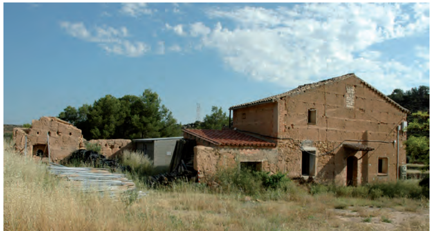
■ Mas del Janet. Edifici rural construït amb parets de tapià on hi vivia permanentment una família que tenia cura de la finca. Disposava de corral adjunt per als animals i d'un forn de pa fet amb toves.
