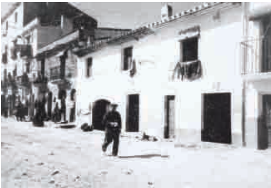
Foto del Carrer Miramar (a l'alçada dels números 18 i 19), ubicat davant de la platja del sorral. Font de procedència: Direcció General d'Arquitectura (1946). Arxiu de procedència: Servei de documentació del Museu Marítim de Barcelona.
