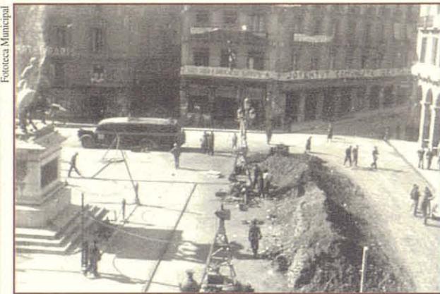
Construcció dels refugis antiaeris a la plaça de Prim el 1937
