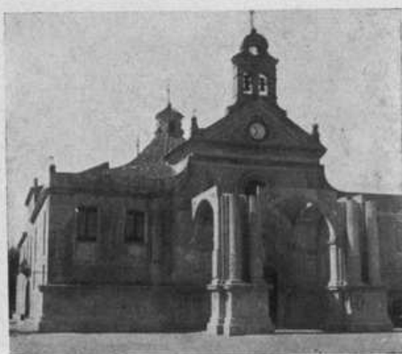
REUS. Estat actual de les obres de la nova façana del Santuari de la Misericòrdia
