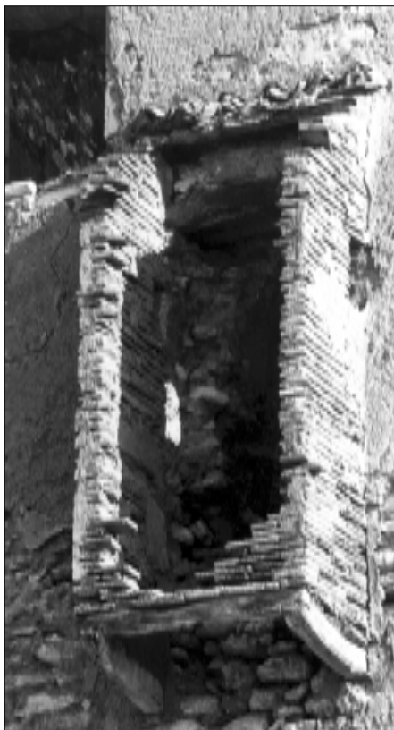
□ Latrina adosada a la façana oest del castell
