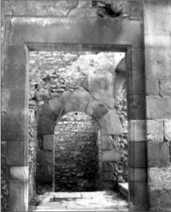
□ Porta d'accés a les escales de la planta principal
