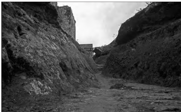
□ Figura 2: Procés d'excavació del fossat del Castell del Catllar (J. M. Vergès).
