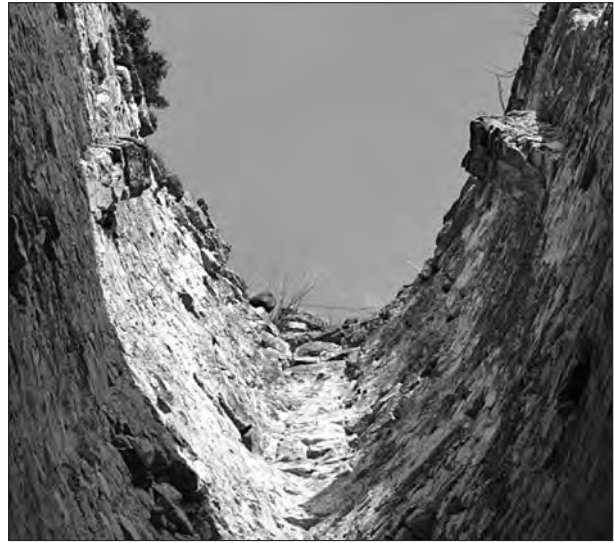
□ Figura 20: Mènsoles a paraments sud-oest i nord.
