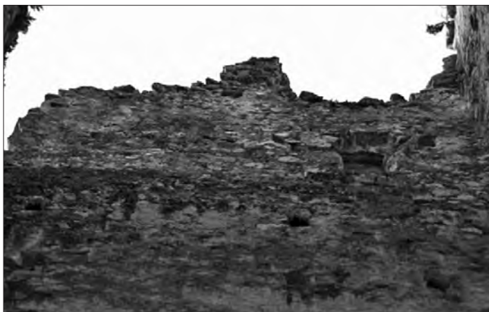
□ Figura 21: Espitllera a parament sud-oest, interior.
