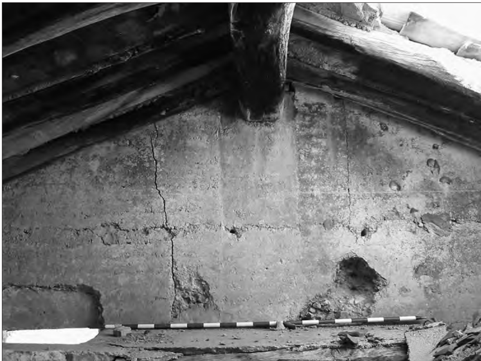
□ Figura 8: Detall del mur de tàpia MR08.
