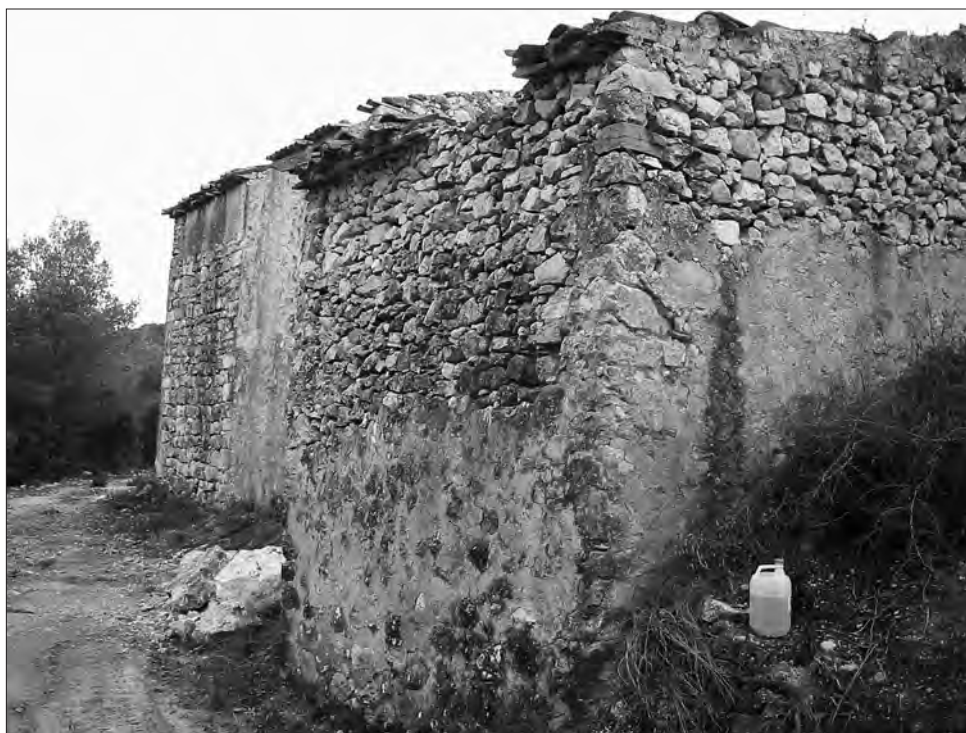
□ Figura 13: El Cos 5, afegit a la façana nord del Cos 3.
