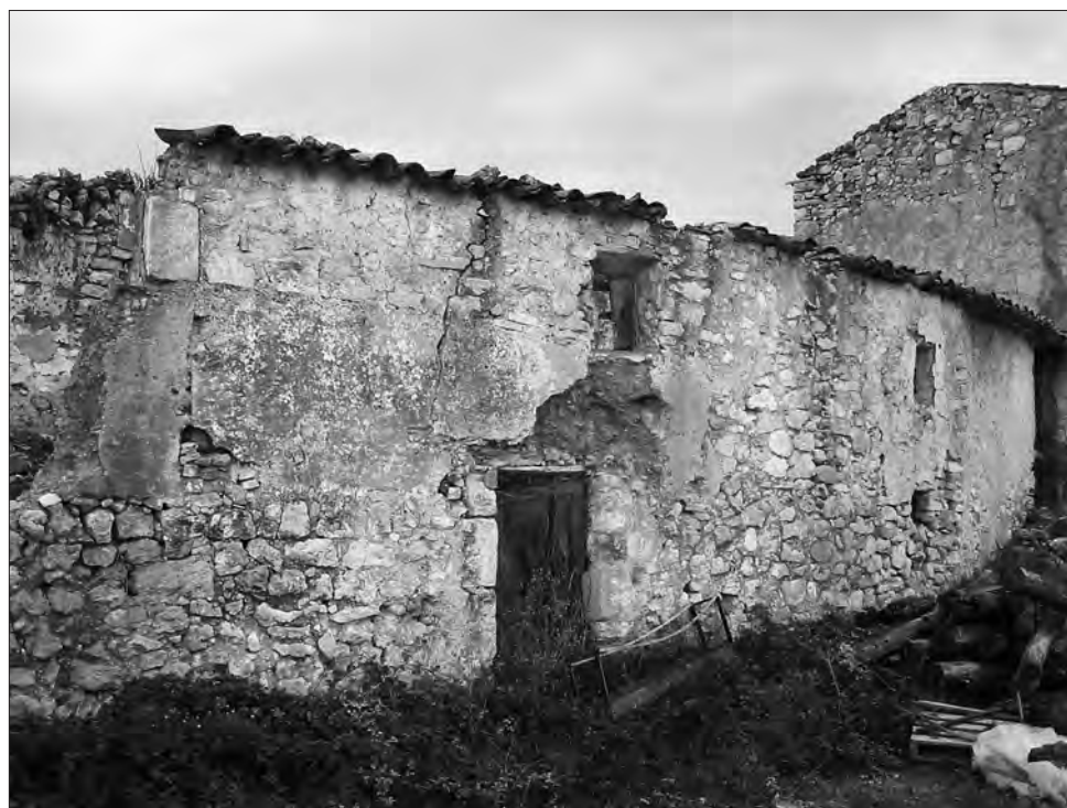
□ Figura 10: Façana de migdia del Cos 4. En primer terme, la porta PR07 i la finestra FN07.
