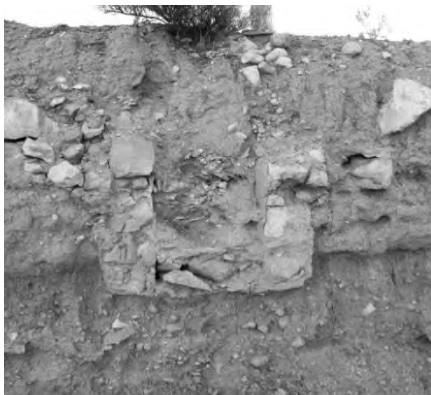
Fig. 3. Detall de la séquia soterrada, en el seu entroncament amb l'aqüeducte, al camí del Molí del Cèntim. Fotografia de l'autor, juliol 2011.
