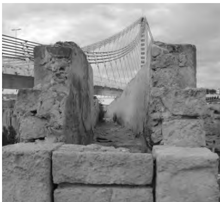
Fig. 4. Detall de la séquia sobre l'aqüeducte, construïda amb carreus i argamassa de morter de calç, acabada amb arrebossat fi del mateix material. Fotografia de l'autor, juliol 2011.
