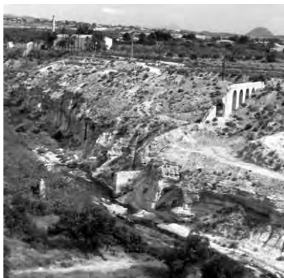
Fig. 7. Vista del vessant est, on s'aprecien les restes de l'aqüeducte i dels pilars de fàbrica on recolzava la canonada de fosa. Al voltant de 1985, abans de la construcció del pont del Bimil·lenari.
