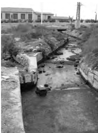
Fig. 2. La séquia Major i el partidor d'Asnell, aquest deriva les aigües cap a l'est pel braçal del mateix nom. Hui el partidor està desaparegut. Fotografia de l'autor, novembre de 2003.
