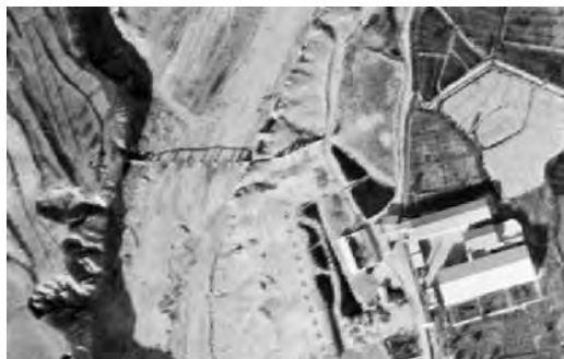
Fig. 1. Fotografia aèria de l'aqüeducte del Vinalopó, on s'aprecia l'ombra de la canalització de fosa, recolzada sobre les pilastres de fàbrica de carreu, al nord de la fàbrica de la societat Ripoll Ferrández y Compañía, pertanyent a la xarxa de reg de la societat La Antisequía, SA. Fotografia aèria de 1929, vol de Julio Ruiz de Alda, Confederació Hidrogràfica del Segura.
