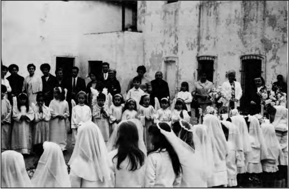
22.Celebració de la processó del Corpus al 1969 davant de la façana de la fàbrica vella que ja havia adquirit i transformat CEMSA. 47
