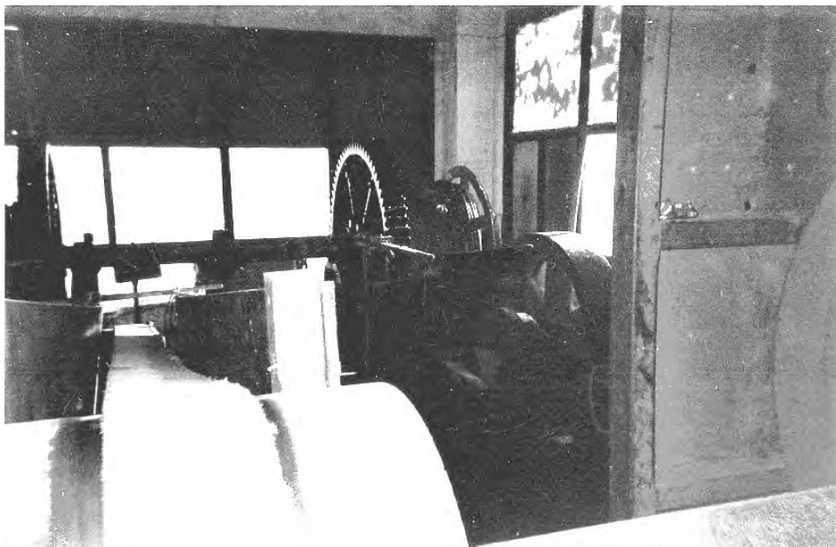
Interior de la "màquina", a l'habitacle del fons, estava instal·lat el motor que feia girar els engranatges. Foto G. Comes
