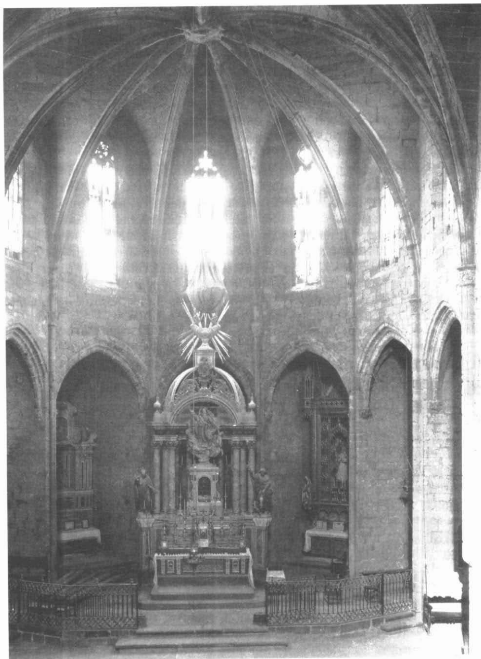
Interior de l'església de Santa Coloma, abans de la destrucció soferta el 1936. Original conservat a l'Arxiu Fotogràfic de la Unió Excursionista de Catalunya. Arxiu Ramon Orga.
