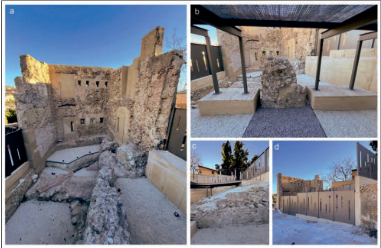
Figura 9. Restos patrimoniales tras la puesta en valor: Vista del interior (a); detalle de la pasarela sobre la muralla del siglo XIII y la continuidad del trazado perdido mediante gravas (b y c); detalle del cerramiento metálico exterior (d).
