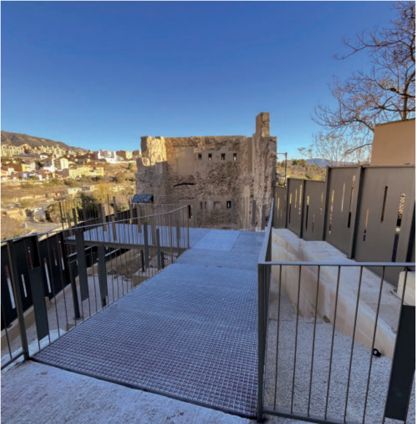
Figura 11. Estado final del conjunto patrimonial tras la intervención de 2023.
