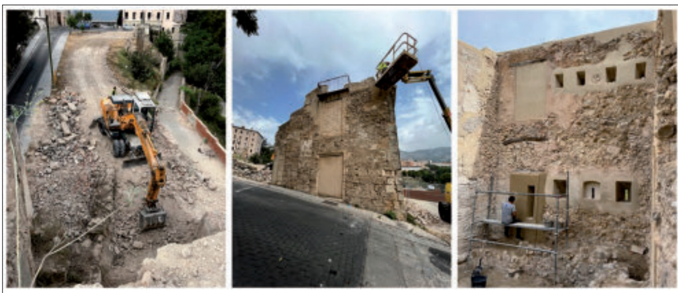
Figura 7. Distintas imágenes del proceso de restauración y consolidación del conjunto patrimonial: retirada de escombros, eliminación de alzados imprimeos, asociados a las viviendas de los siglos XIX-XX y restauración de aspilleras en alzado interior.
