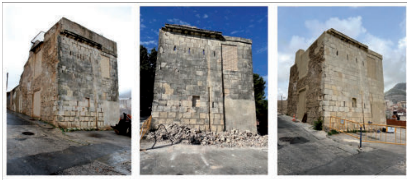
Figura 8. Tres instantáneas de la recuperación del frontal de la fortificación del siglo XIX. Desde 2019 hasta los trabajos de 2023.
