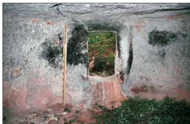
Figura 12. Interior de BR 6; amb la seua finestra.
