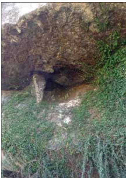
Figura 21. Vista del que resta de BR 14.
