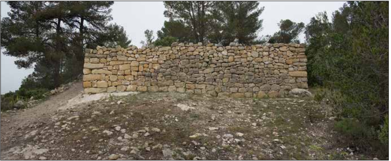
Fig. 13. Vista frontal de la torre donde se aprecia el apoyo sobre roca madre.
