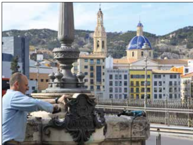
Reposició d'una de les plaques artístiques de bronze del Viaducte de Canalejas.
