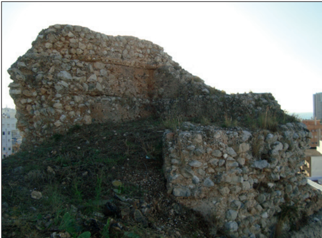
Figura 4. Estat previ de la torre Miranda.
