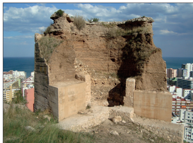
Figura 2. Estat previ de la torre Octogonal abans de la campanya d'excavació i consolidació.
