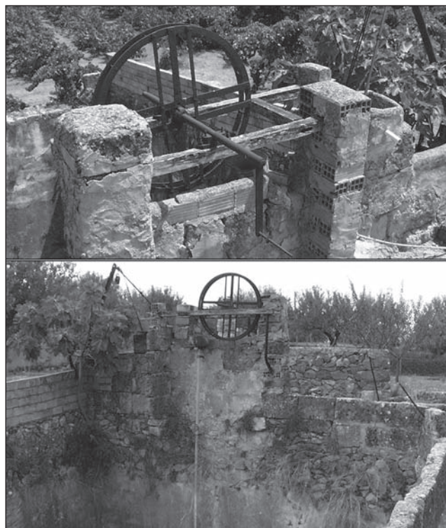
Figura 26: Sénia de la Casa del Capellà, vista de la manovella (dalt) i de la bassa i el tub per on passava la cadena (baix) (Font: l'autor)
