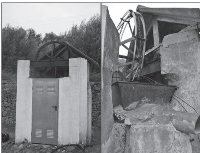
Figura 25: Sénia del metge Juan Burguera (esquerra) amb detall de la roda, el rosari i la pastera a la dreta (Font: l'autor)
