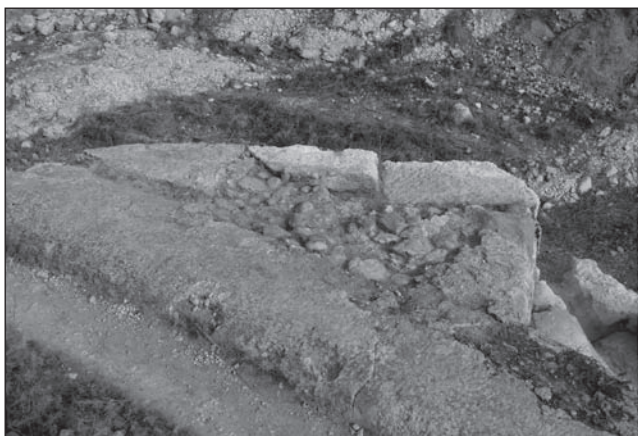
Làmina. XI. Estrep occidental. Vista superior. Sondeig nº 2. Observeu el reblit i com la contraséquia del s. XVIII se superposa a l'obra anterior.
