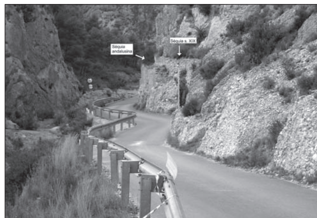
Làmina. XII. Vista de la séquia andalusina enlairada creuant la Tanca del Forat. Observeu el fort pendent que mena al molí seccionat per la carretera.
