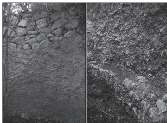
Figures 3 i 4. A l'esquerra, paret del forn d'Albinyent, enlluïda i amb el mur damunt; a la dreta, banqueta on es recolza la volta de pedra del forn Cocentari I (font: l'autor).
