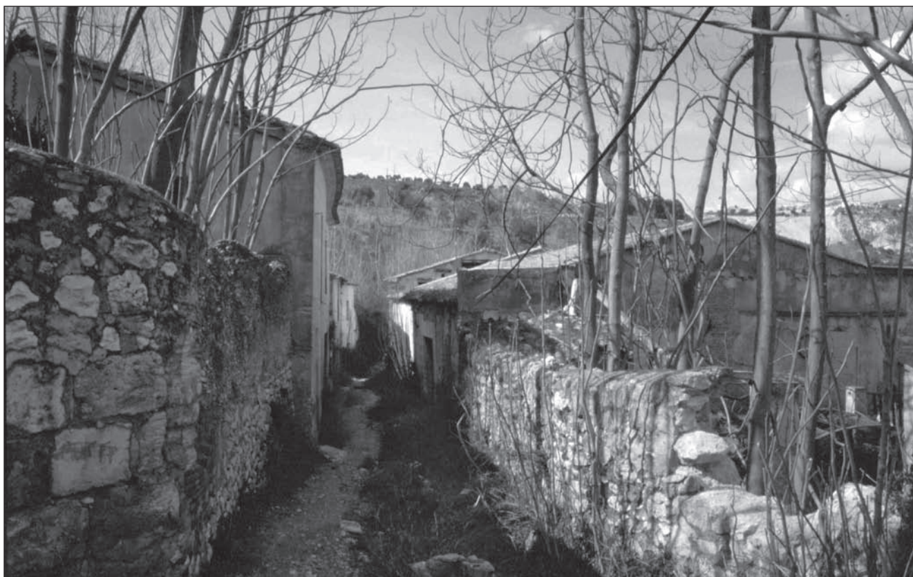
Lámina 6. Fachada lateral Sur del molino papelero (estado en 1990). Foto M. Pérez - IGS, Ayuntamiento de Alcoy.
