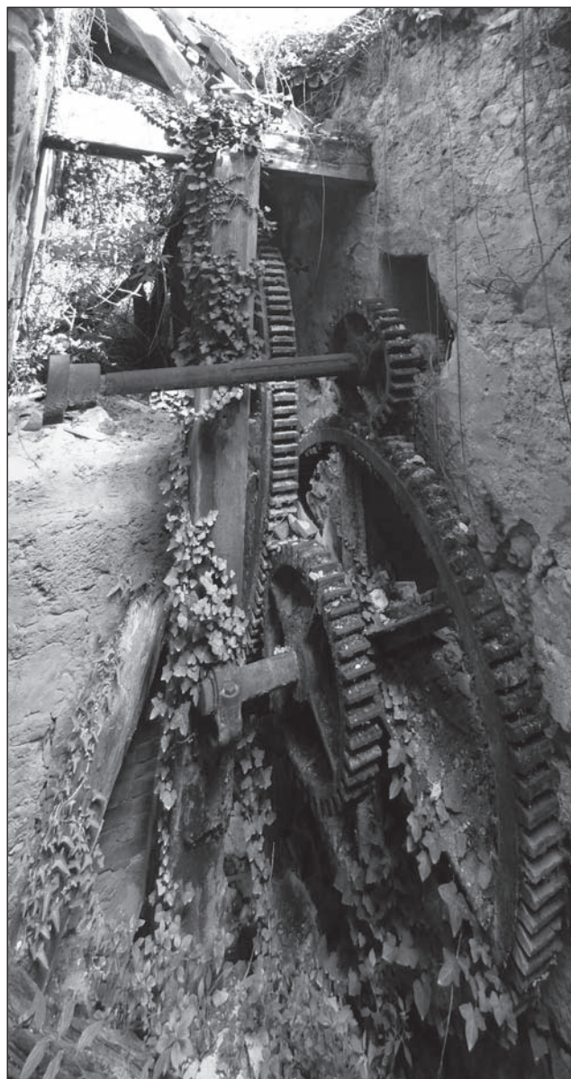
Lámina 12. Mecanismo de transmisión del movimiento rotatorio de la rueda hidráulica al embarrado del edificio (estado en 2012). Foto Museu Arqueològic d'Alcoi.
