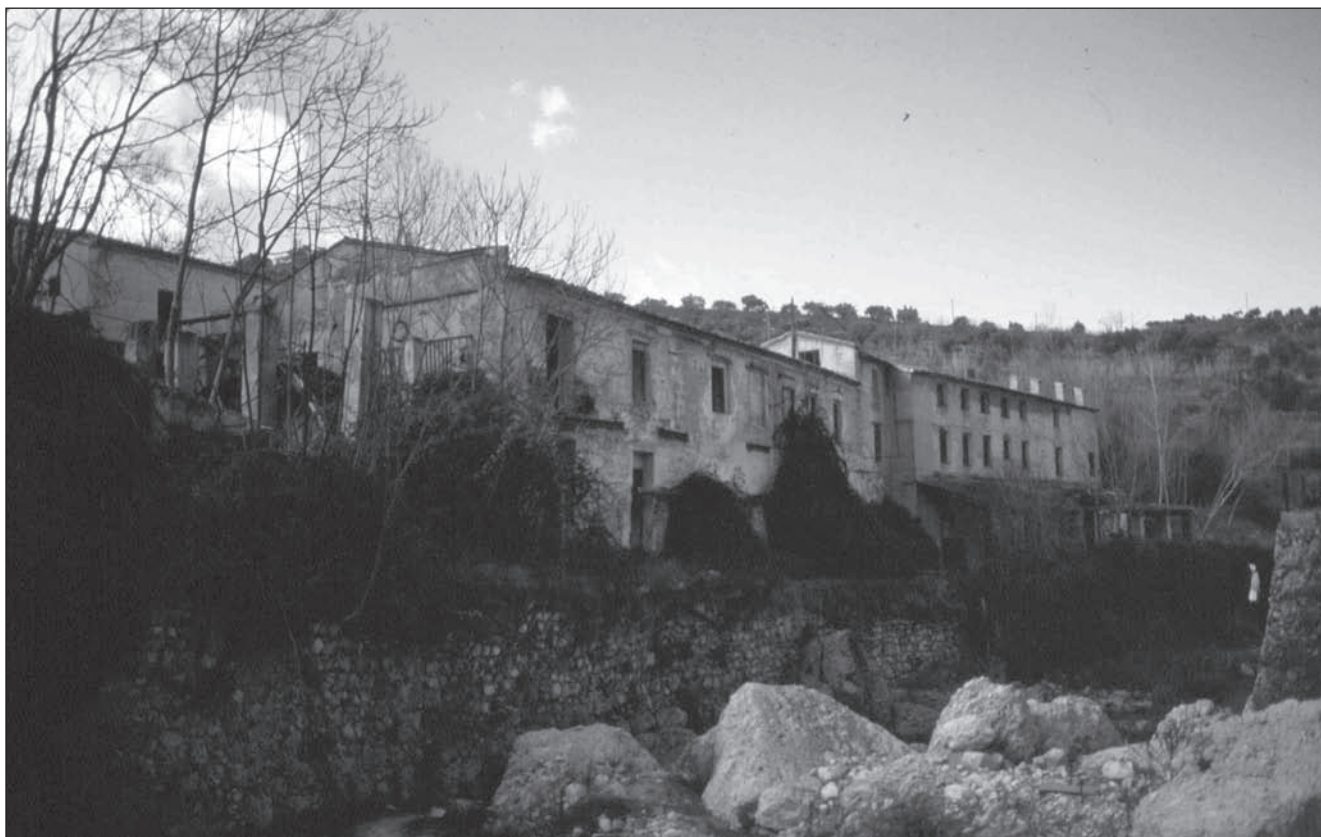
Lámina 5. Fachada principal del molino papelero (estado en 1990). Foto M. Pérez - IGS, Ayuntamiento de Alcoy.
