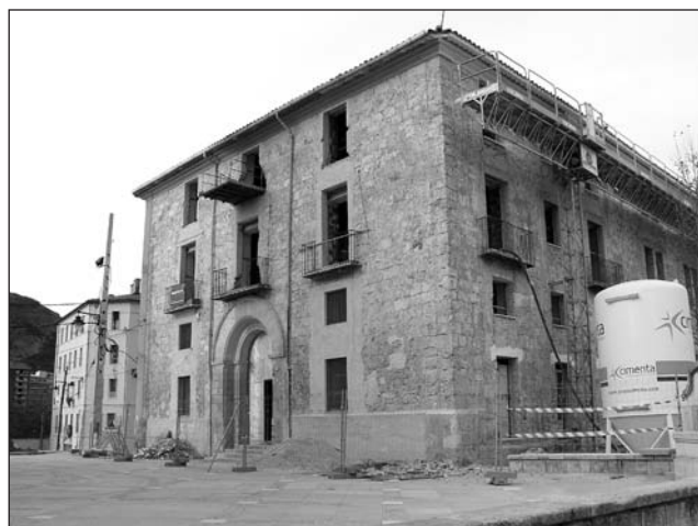
Lámina III. Fachada principal y lateral SE (c/ Sant Miquel).
