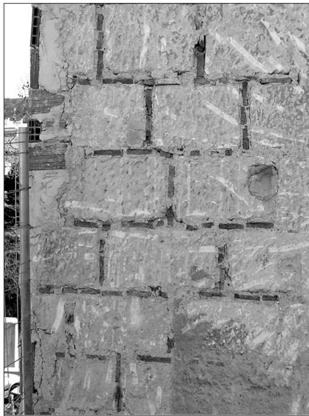
Lámina X. Verdugadas de ladrillo calzando sillares de la esquina NE.
