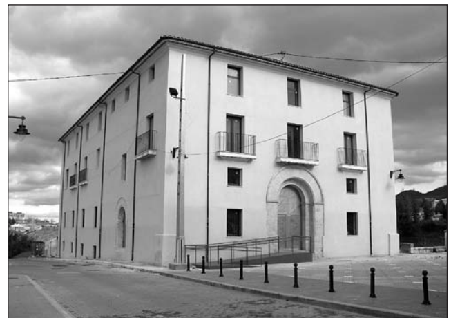
Lámina XV. Edificio rehabilitado (2007-2008) del antiguo Hospital de Nª Sª de los Desamparados.
