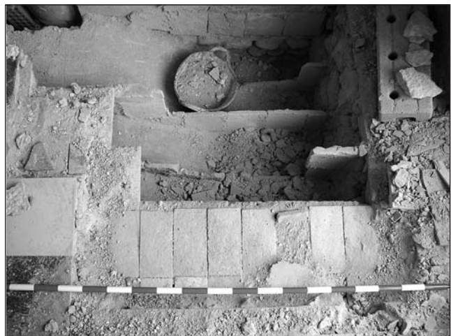
Lámina XIV. Excavación de los pavimentos y tabiquillos sobre la bóveda de ladrillos del antiguo hospital.
