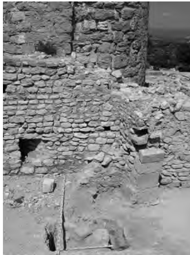
Imatge 3. Tram de muralla sota paviment entre les dues fletxes. Es pot veure l'empremta negativa (fletxa superior) que ha deixat a la torre rodona i que ens indica que la torre es va construir en una fase posterior a la muralla. Les dues fletxes a la part baixa de la foto senyala l'amplada i localització de la muralla andalusina sota els paviments i seria la que encaixaria la torre rodona.
