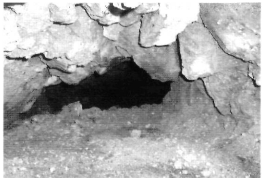
Imatge 12. Sèquia que discorre enmig del vall, per sota de la plaça de la Diputació. Es troba colmatada de terra, però feia quasi 1 m d'altura interior. Es troba coberta per una volta de canó amb pedres col·locades a mode de llibrel. Font: Escola Taller "L'antic Hospital".
