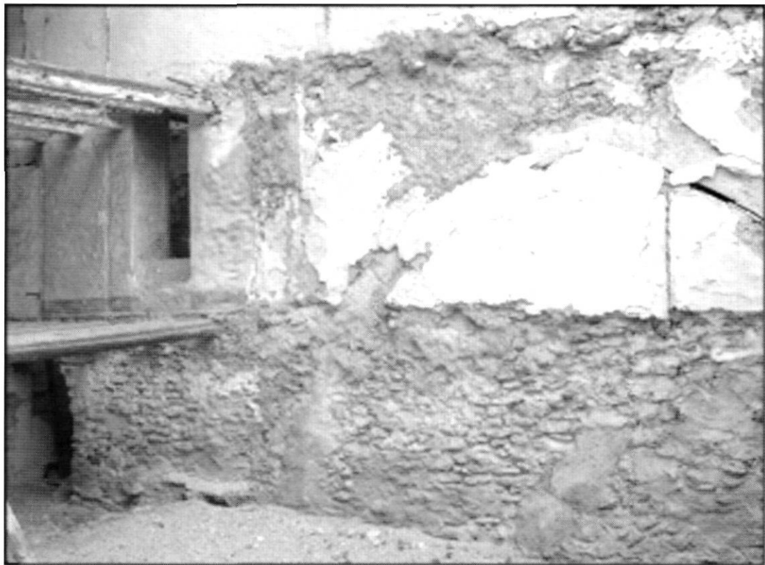
Imatge 22. Detall d'una arcada apuntada que feia la funció de jàssera. Font: Elaboració pròpia
