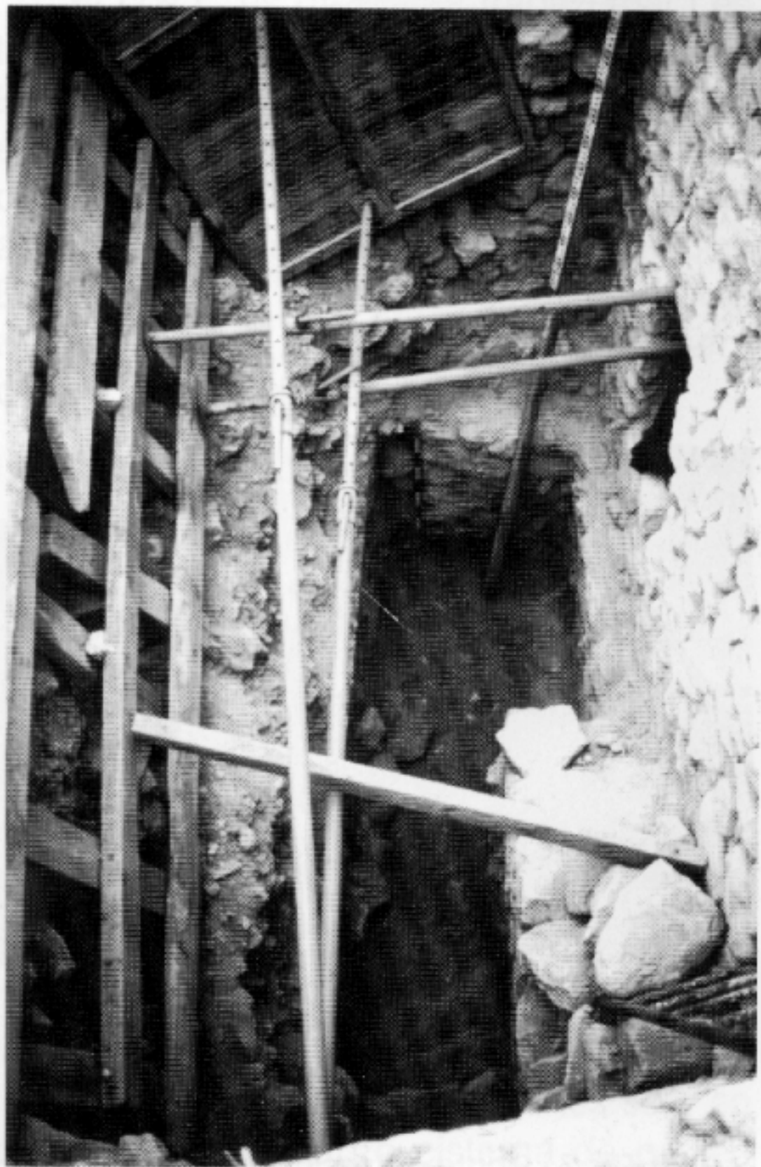
Fig. 5 - La inconsistència del tall estratigràfic va fer necessari assegurar i apuntalar mitjançant taulons i telescopis metàl·lics el sondeig VI.
