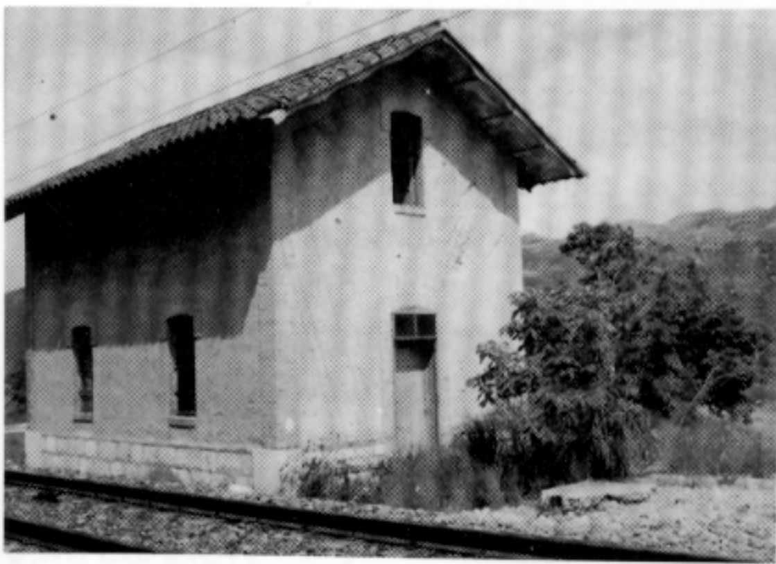
Instal·lacions ferroviàries dins l'espai original de la bassa del Coll. Actualment la caseta ha estat enderrocada amb motiu de les obres de la doble via del ferrocarril.
