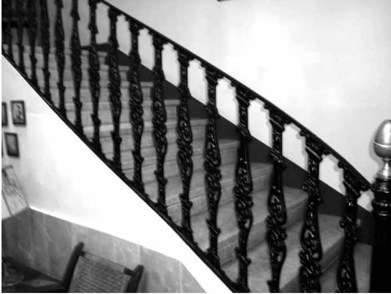
Detall de la balustrada de ferro forjat (Font: fotografia d'elaboració pròpia)
