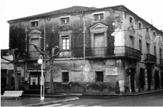
Vista de la façana lateral; observem les dos finestres de la planta baixa (Font: fotografia cedida per Maria Rita Yvars)
