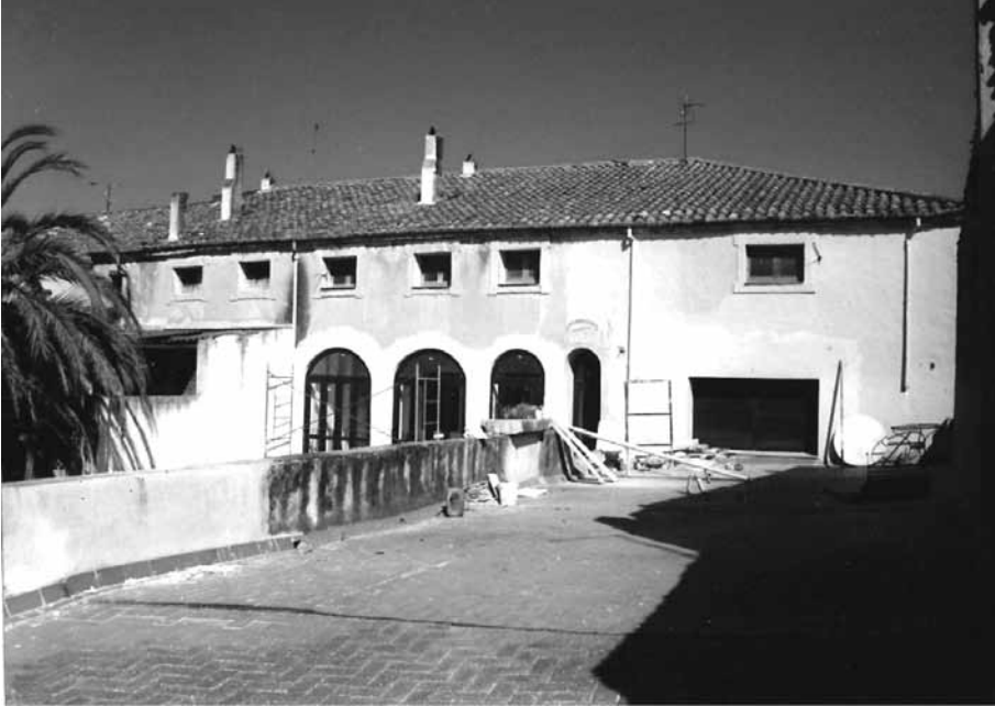
Façana posterior que aboca al gran jardí i a la terrassa, que veiem en un primer pla (Font: fotografia cedida per Maria Rita Yvars)
