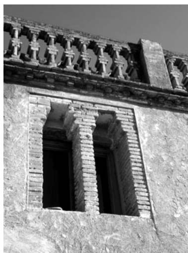
Detall de la finestra lateral i la barana del terrat
