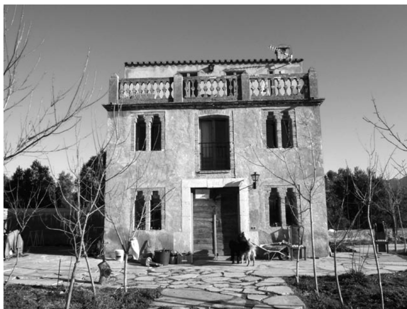
Mas de Bocanegra. Façana principal.
