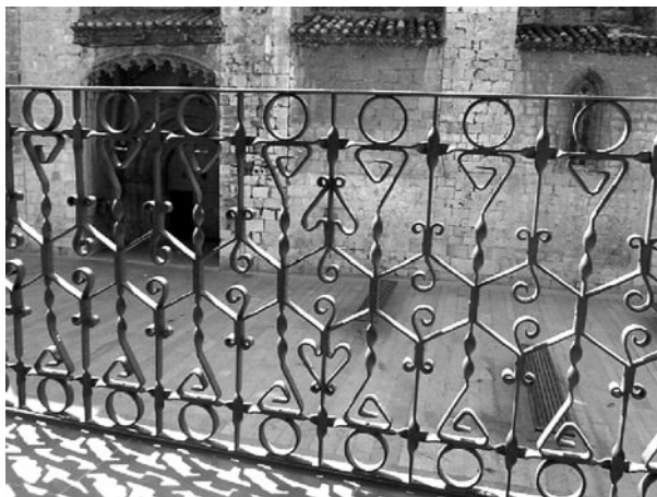
Barana de ferro forjat del balcó del primer pis
