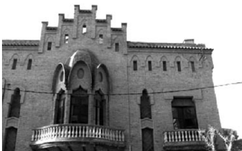
Federació Obrera de Molins de Rei. La tribuna presenta evidents similituds amb la de la Casa de la Feligresa. Especialment en la manera de concebre'n la coberta.
