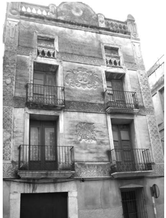
Casa construïda a principi del 1900, situada al passeig de l'Estació. Es noten els estils arquitectònics del moment, pel treball a la façana d'emmarcaments dels balcons amb motius ornamentals, i la separació dels diferents nivells amb formes ornamentals. la casa és propietat de Maria Sans. (FONT: Elaboració pròpia ).
