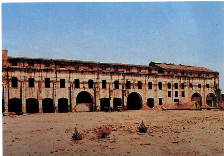
Foto 11: Edifici que formava part de l'antiga caldereria dels tallers de la Barceloneta vist un cop que van ésser enderrocats els edificis annexos (Foto: ICC) (Font: La Maquinista )
