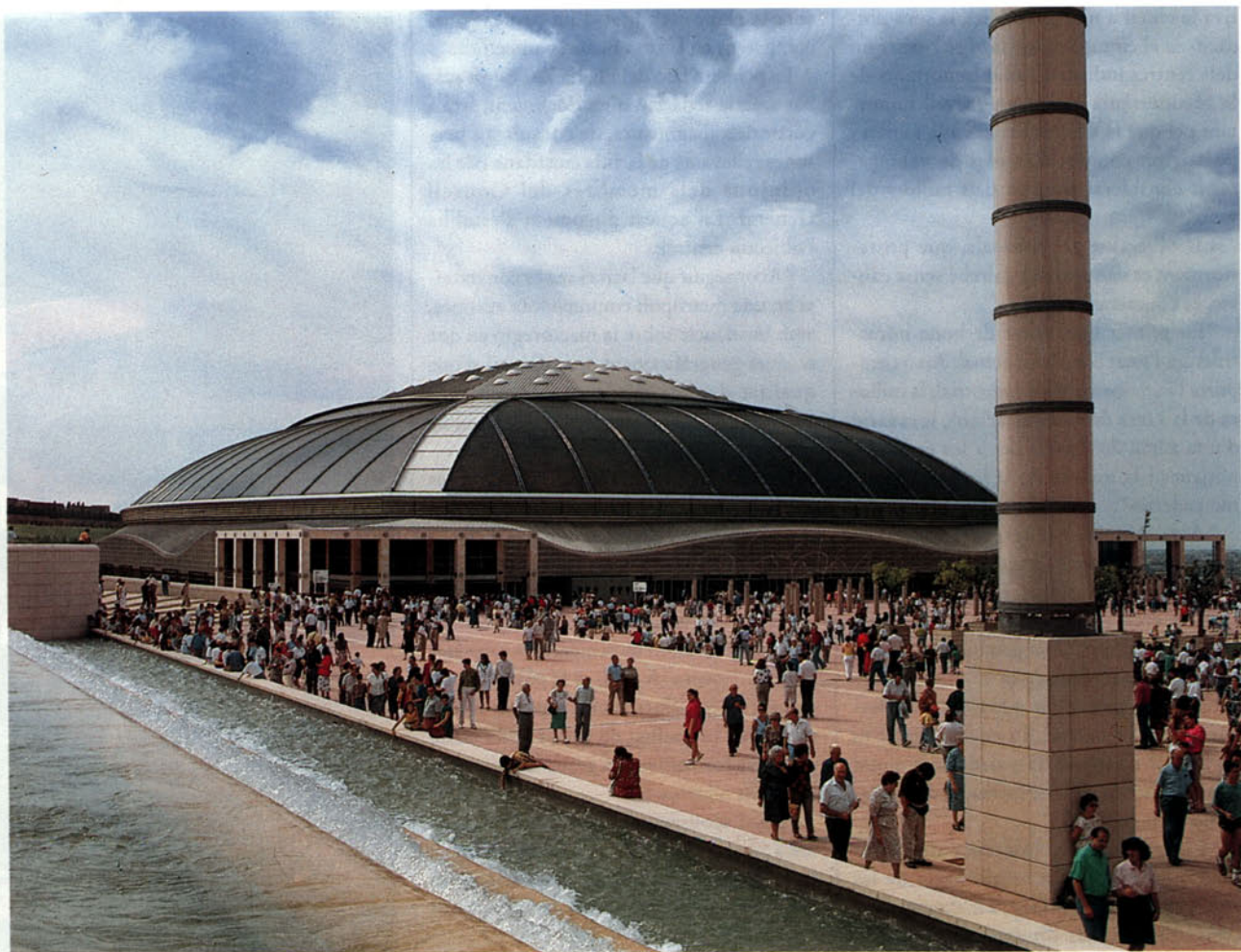
El palau Sant Jordi, de l'arquitecte japonès Arata Isozaki, centra la remodelació de l'anella olímpica
