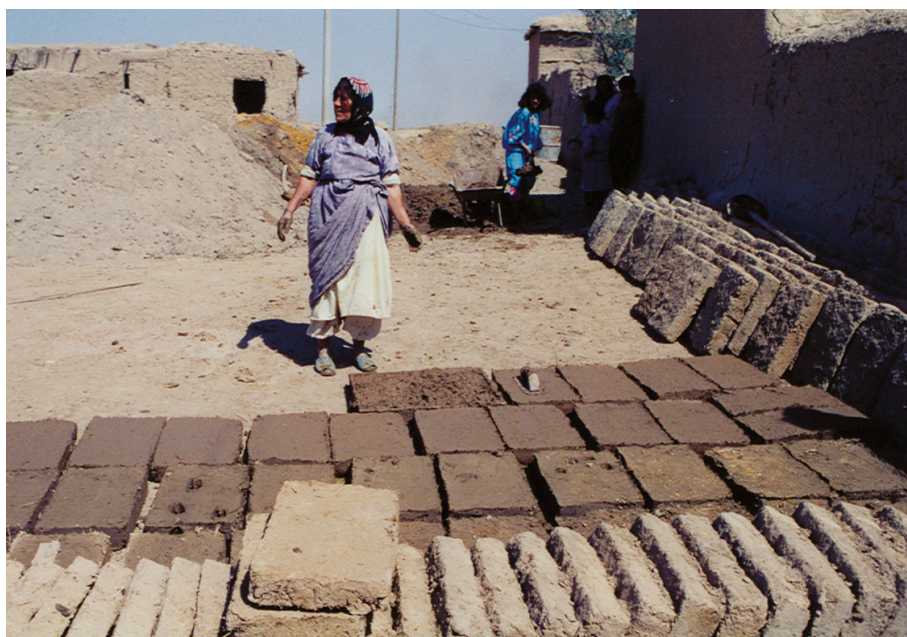
Figure 4. Moulage des briques à Tell Leilan (Syrie), années 1990 (cliché M. Sauvage).
