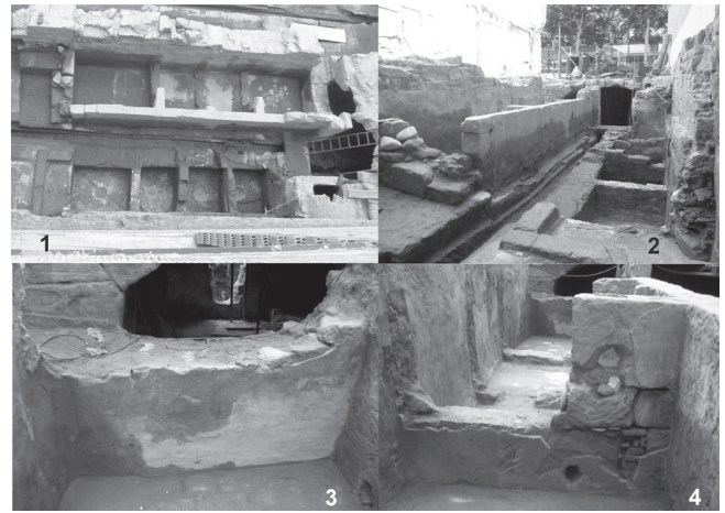
Fig. 67. 1/2. Vista general de les dues bateries de quatre clots ara construïdes davant de la volta del celler; 3. Detall de la paret de tancament est de la bateria nord de dipòsits (u.e.: 1048), tapiant part de la llum de la volta del celler de tint; 4. Detall d'un dels envans de separació interiors (u.e.: 1049). Observeu els revestiments hidràulics de totes les parets interiors.
