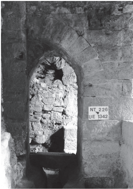
Fig. 24. Detall de la porta de comunicació entre les adoberies localitzada davall de les voltes de suport del carrer Blanquers. Al fons el tapiat de la porta de comunicació amb la suposada adoberia núm. 7.
