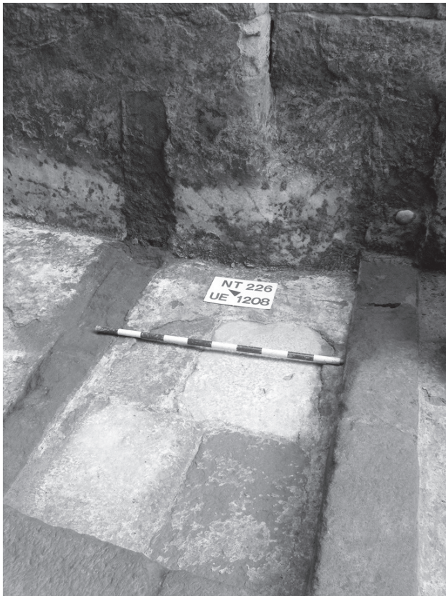
Fig. 31. Detall d'un dels calciners de la bateria nord on s'aprecia molt bé les lloses, el revestiment hidràulic del terra i els murs que delimiten l'interior. Observeu com la paret del fons és irregular ja que el revestiment s'adapta al mur de divisió central, que en aquest punt està compost per dos plans diferenciats, el de l'estrep de l'arc més gruixut que el tapiat de la seva llum.
