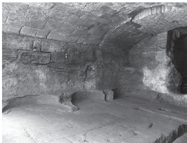
Fig. 34. Detall de la paret de tancament nord del celler, arrencament de d'intradós de la volta i restes dels dipòsits circulars. Al fons, la paret de tancament fluvial i el brancal nord de la porta de sortida.
