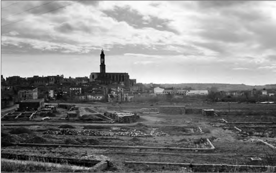
La Fraternal, 1961. Construcció de les cases del barri de la Fraternal. Autor: Guri. Arxiu Municipal de Valls.
