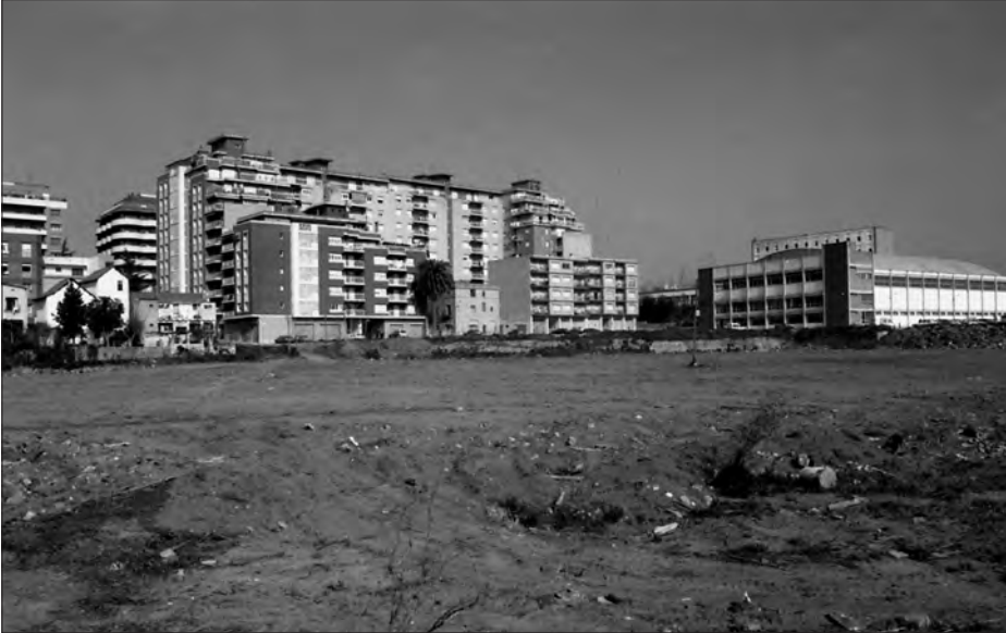
El Vilar, 1990. El Centre Cultural encara per construir. Al fons, la palmera (Phoenix canariensis) que actualment hi ha davant del Centre Cultural. Autor: Jep Martí. Arxiu Municipal de Valls.
