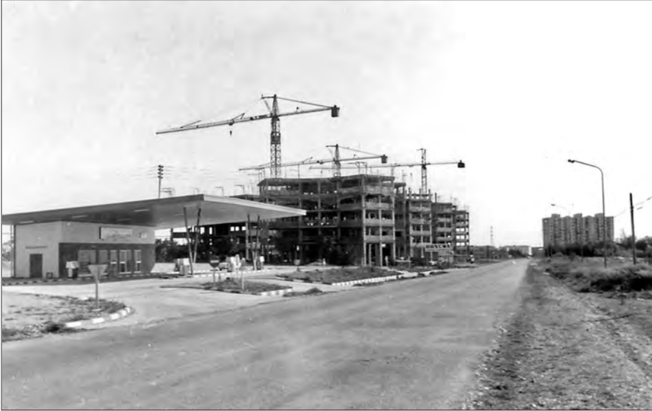
Carretera del Pla, 1977. Construcció dels pisos de Santa Úrsula, i terrenys erms. Autor: Galimany. Arxiu Municipal de Valls.
