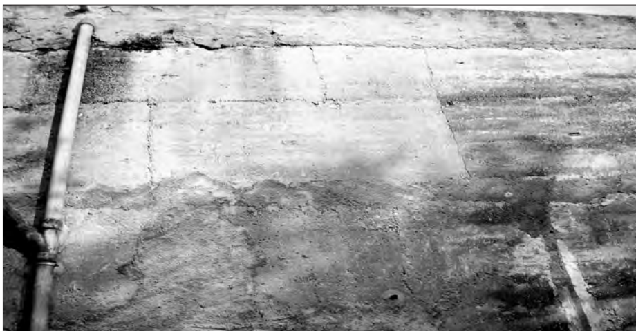
Mur exterior de l'ermita del Roser de Vallmoll. Josep M. Torrell Pareta
