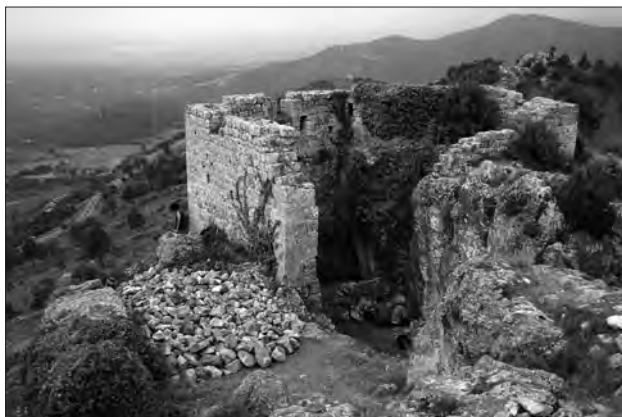
Figura 3: Visió general de l'estructura poligonal o baluard vers l'oest.
