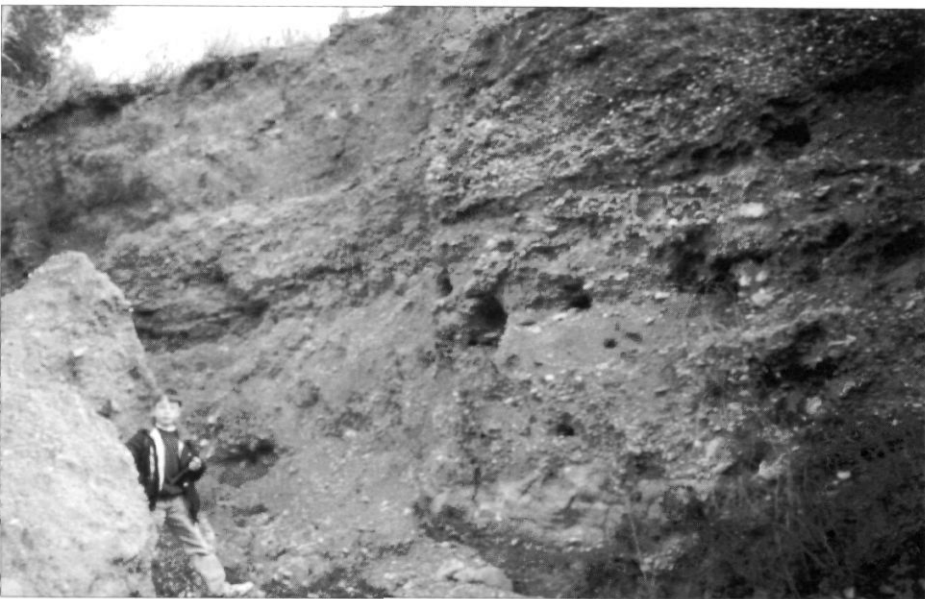
Fig. 15. Erosió a la rasa del Serraller
