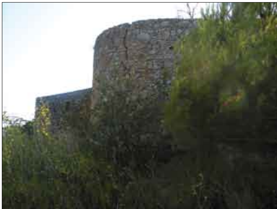
Base de la torre de defensa que fou dels cavallers Bedós, avui ermita de Sant Daniel (Sant Antoni de Calonge).
