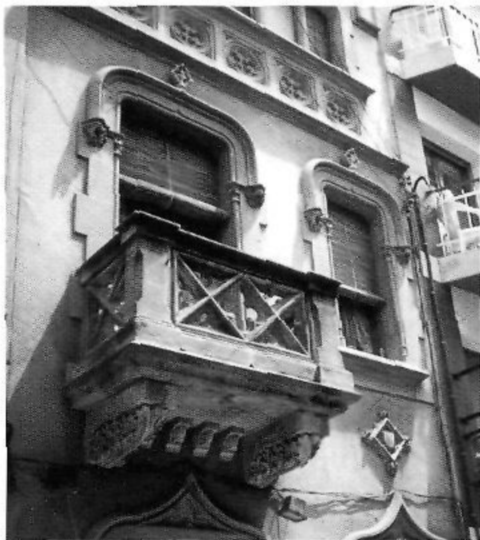
Balcó de la Casa Llubí (carrer de Sant Pere).
